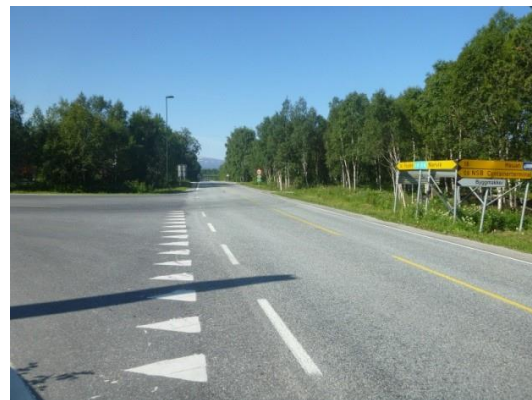
Kryss E6/Terminalveien sett mot sør.
