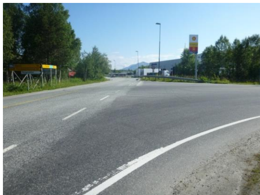
Kryss E6/Terminalveien sett mot nord.
